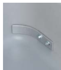
Pritschenbefestigung (Verstärkung)
