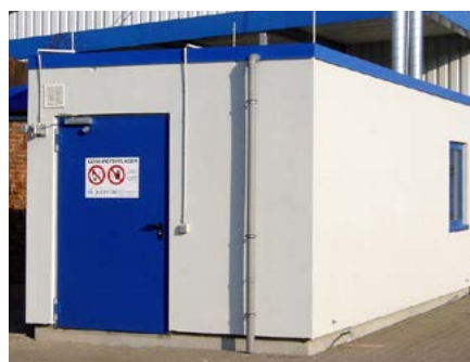
F90 Brandschutzlager als begehbare Variante
